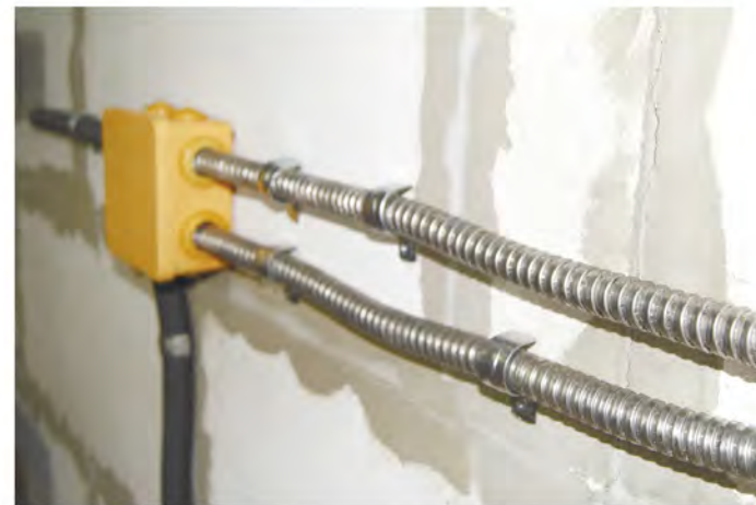
Прокладка кабеля в металлорукаве
