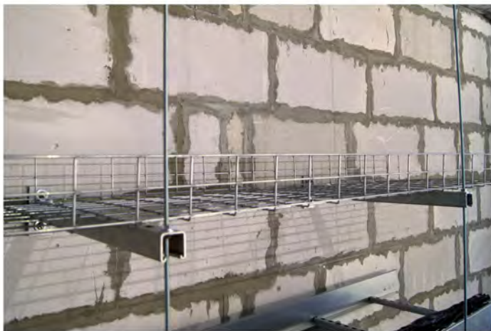
Крепление металлического проволочного лотка при помощи кронштейнов
