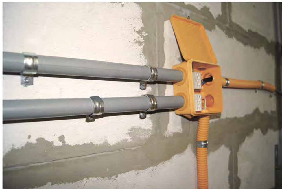
Прокладка кабеля в гладких жестких трубах, разводка кабеля в распаячной огнестойкой коробке
