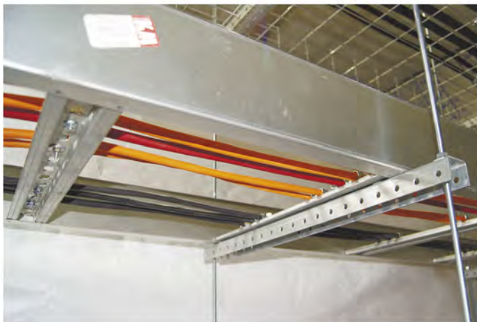
Прокладка кабеля в лестничном лотке (вертикальный подвес лестничного лотка на шпильках к бетонному перекрытию)
