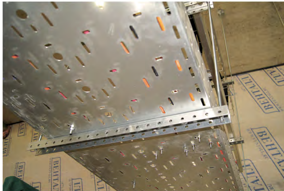
Вертикальный подвес металлического лотка на шпильках к бетонному перекрытию
