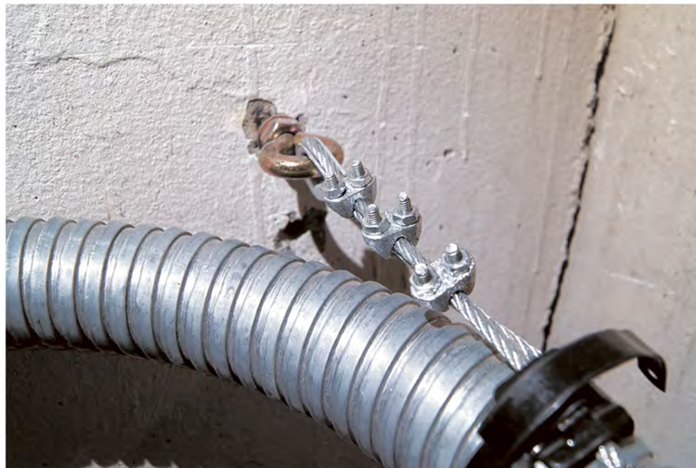
Вариант крепления стального троса к вертикальной опоре с использованием анкерного крюка и одинарных зажимов
