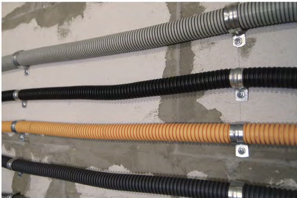
Крепление гофрированных труб с помощью скобы однолапковой (вариант исполнения)
