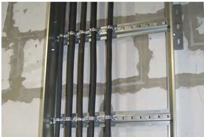
Прокладка кабеля в лестничном лотке (вертикальное исполнение)
