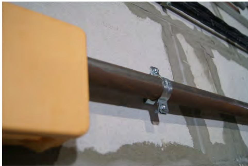
Прокладка кабеля в трубе стальной электросварной при помощи дистанционных скоб, ввод кабеля в распаячную огнестойкую коробку «Рувинил» (вариант исполнения)
