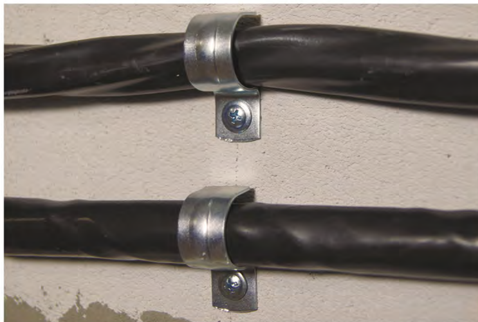
Вариант крепления открыто проложенного огнестойкого кабеля
