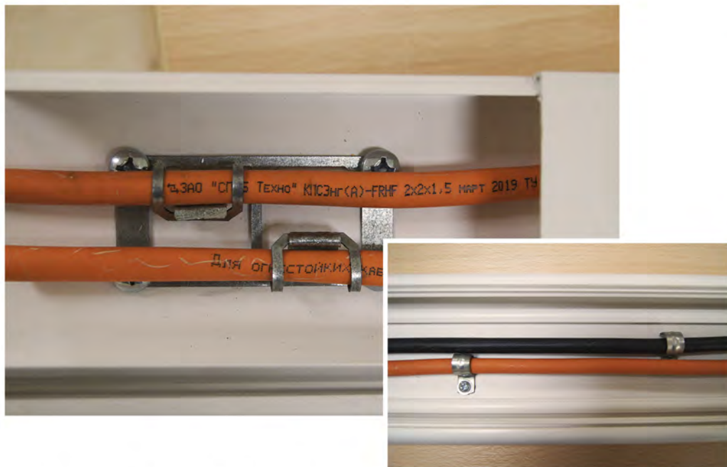
Крепление кабеля в кабельном канале с использованием универсального держателя ДМОУ (либо с использованием скоб)
