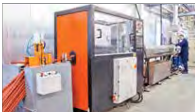
Линии для экструдирования термоусаживаемой трубки
