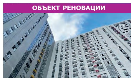
ЖК «Косино-Ухтомское», инженерные коммуникации, благоустройство, Москва
