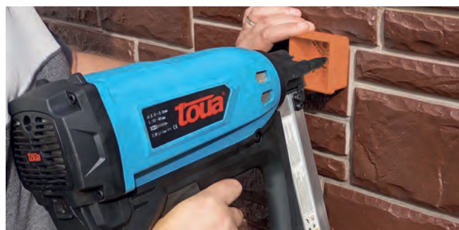
Использование газового монтажного пистолета
