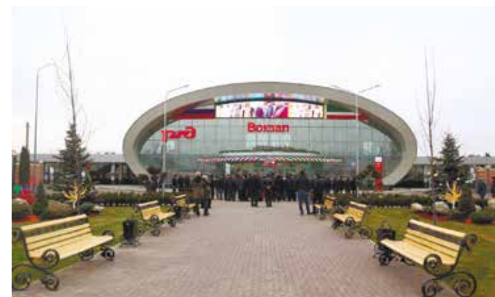
вокзал «Гудермес», г. Гудермес Установленные системы: ПС, СОУЭ, ОС, ПТ.
