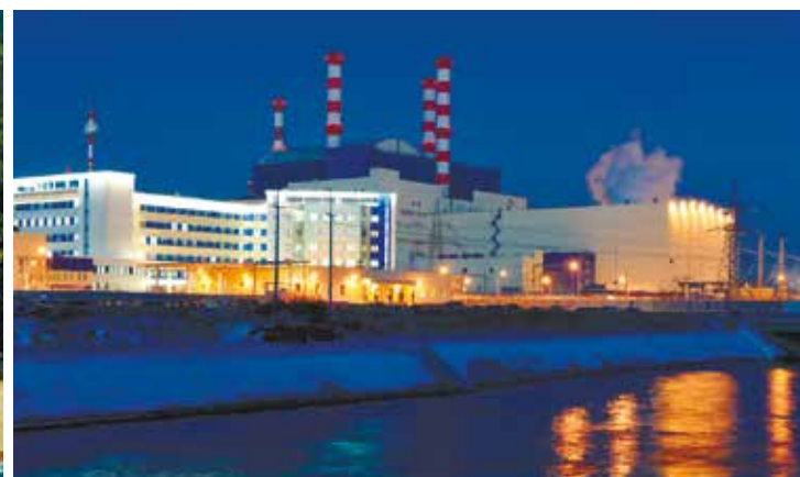
Белоярская АЭС, г. Заречный Установленные системы: ПС, ППТ, ГПТ, ВПТ.
