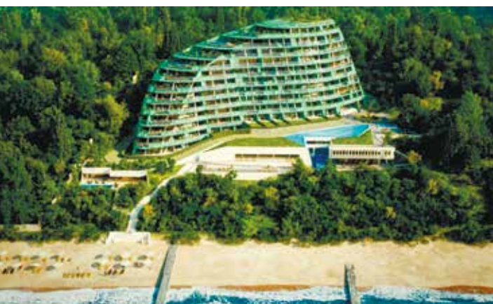
гостиница «Reef residence», г. Сочи Установленные системы: ГПТ, АДУ.
